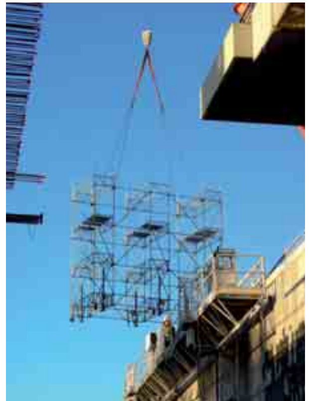
Izado de Cimbra BRIO
