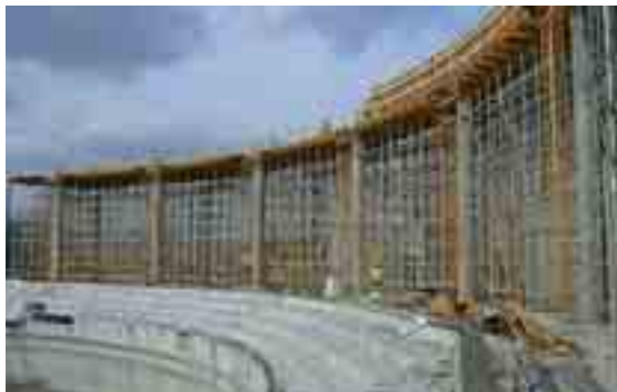
Cimbra BRIO apeando encofrado ENKOFLEX en el Velódromo de Palma de Mallorca, España
