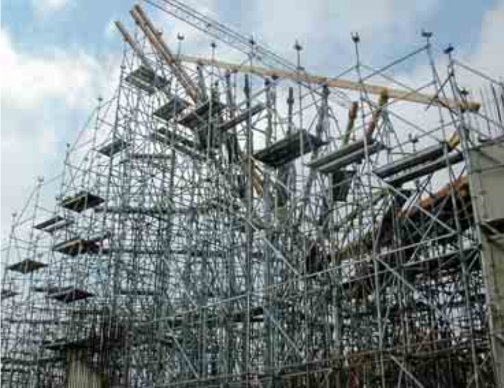
Plataformas de trabajo en la Cimbra BRIO para la colocación del encofrado
