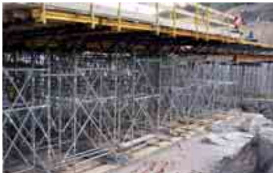
Apeo de tablero de puente mediante la Cimbra BRIO
