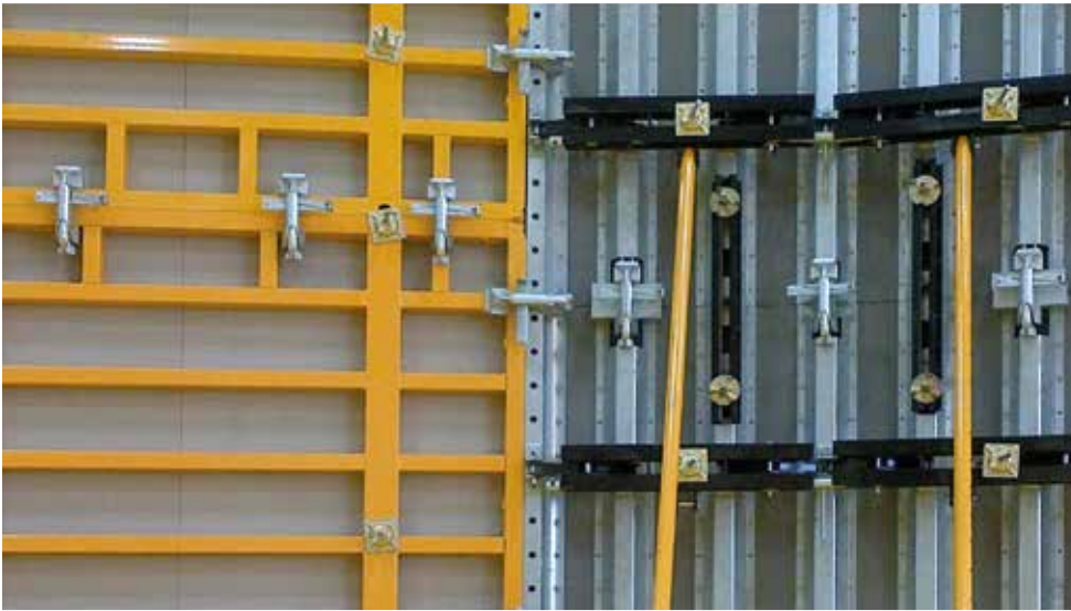
► Mismos accesorios en diferentes encofrados
