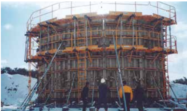
► Accesos y plataformas de trabajo en diferentes niveles
