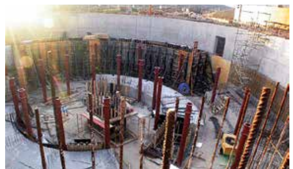
► Cerchas EUC de encofrado a una cara unidas a paneles BIRAMAX
