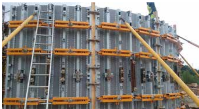
▶ Paneles unidos mediante grapas ORMA tanto vertical como horizontalmente
