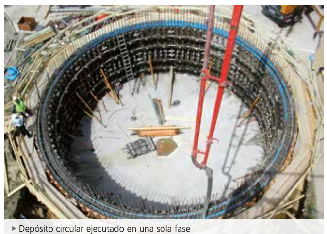
► Depósito circular ejecutado en una sola fase
