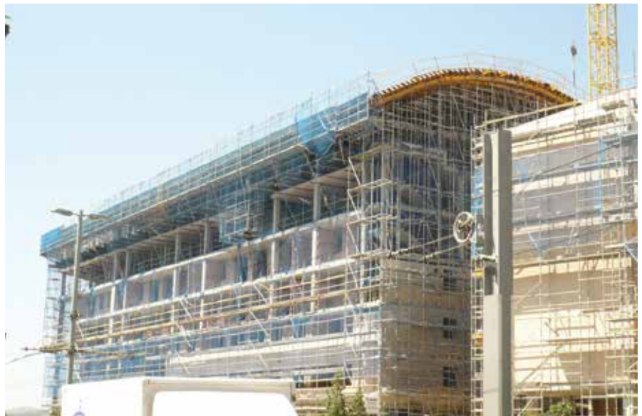
► Superficie inclinada con ENKOFLEX sobre cimbra
