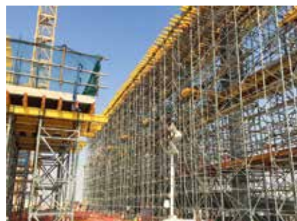
► Apeo a gran altura con cimbra T-60
