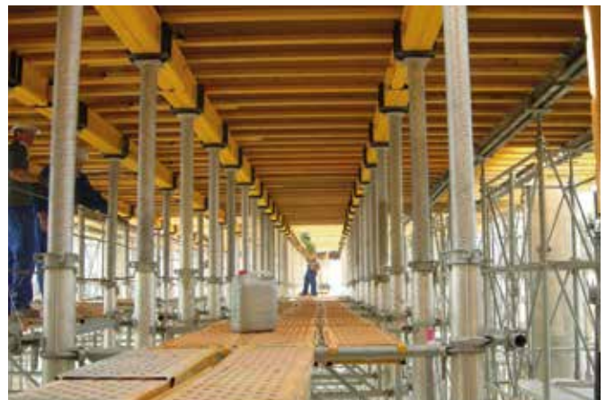
► Plataformas de montaje del encofrado sobre torre de cimbra
