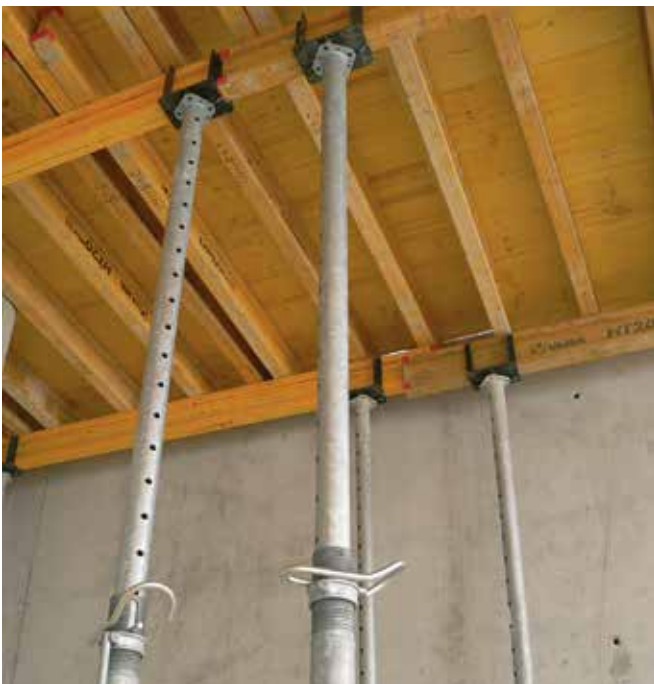
► Encofrado contra muro sencillo con solape de vigas
