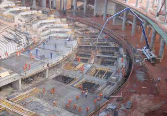
► Ejecución de vigas de cuelgue intermedias y perimetrales
