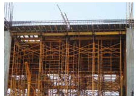
► Apeo en edificación con cimbra G
