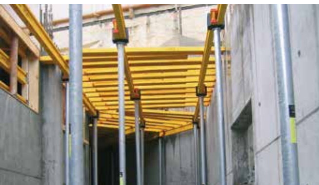
► Encofrado contra muro sencillo con solape de vigas
