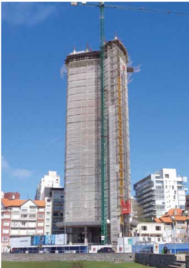
► Ejecución de losas de geometría irregular
