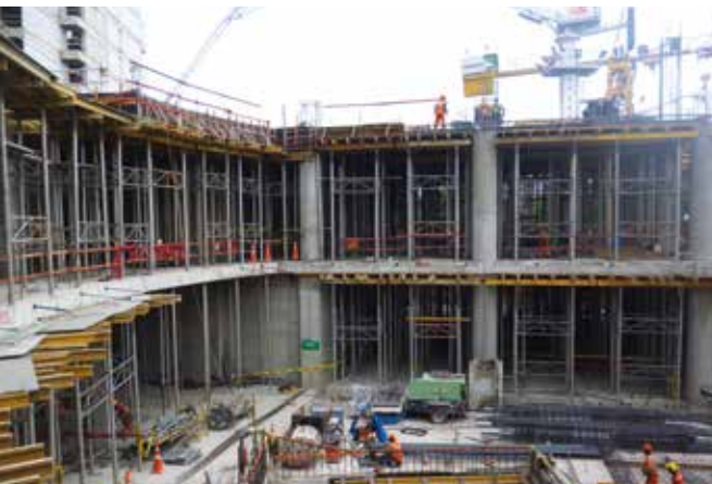
► Apeo de grandes cargas con torres ALUPROP
