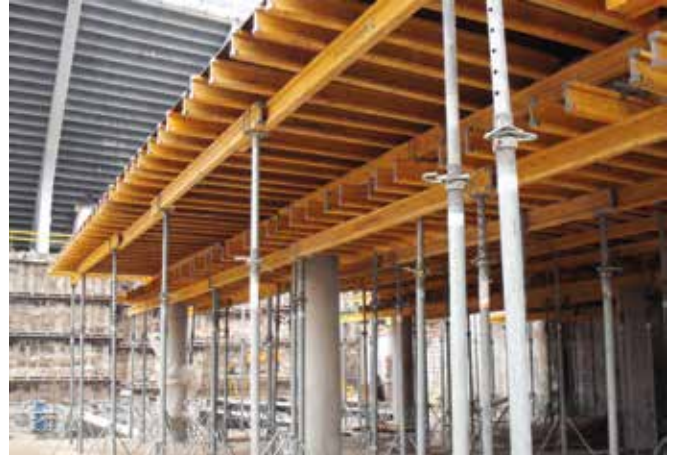
► Vigas de madera a distinto nivel
