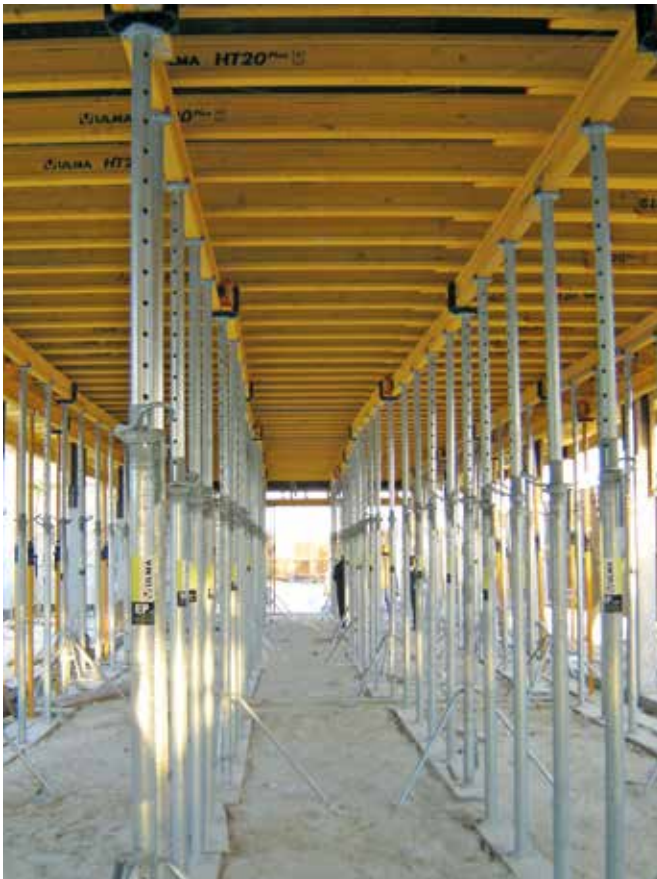
► Pocos elementos diferentes de encofrado
