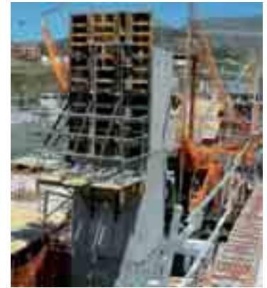
Consolas BF-170 con encofrado vertical ORMA
