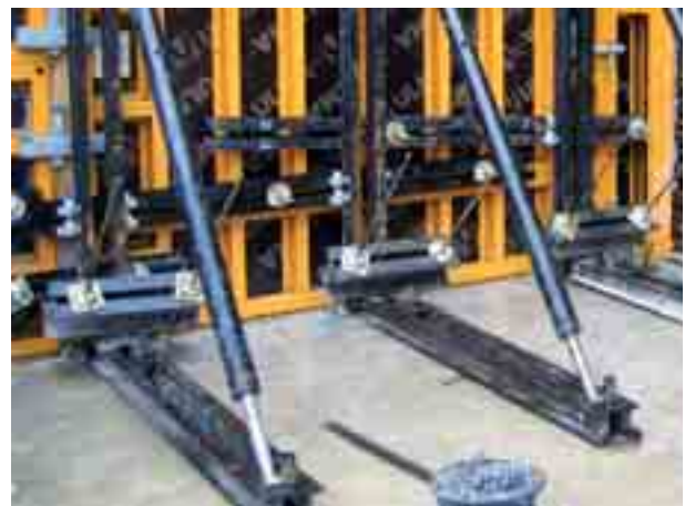
Anclaje del conjunto a la solera
