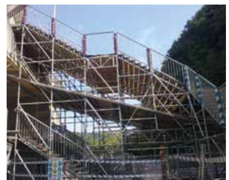
▶ Puente atirantado Hisgaura, Colombia. Escalera de aluminio de 142 m
