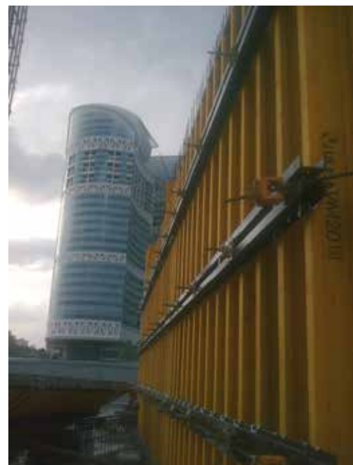
▲ Vigas VM-20 en el encofrado vertical ENKOFORM V-100 ▲
