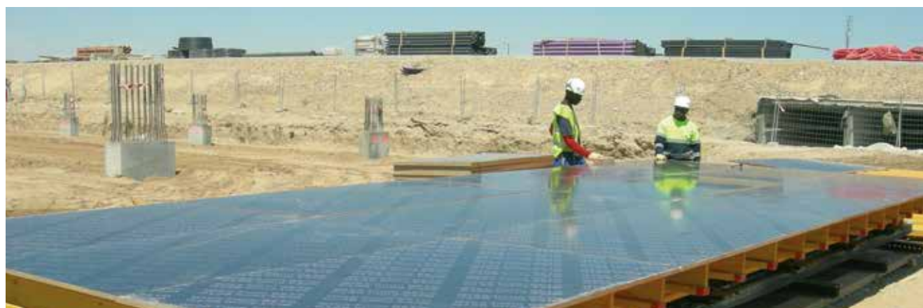
▲ Montaje del encofrado horizontal Mesa VR con tablero fenólico y vigas de madera VM-20.
