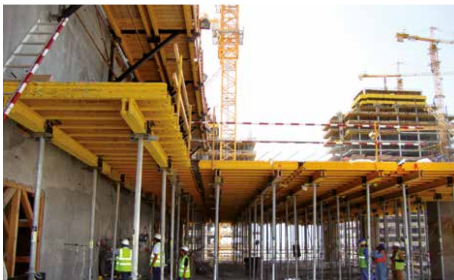
▲ Vigas VM-20 en el encofrado horizontal Mesa VR y en la Consola de Trepado para conformar plataformas de trabajo
