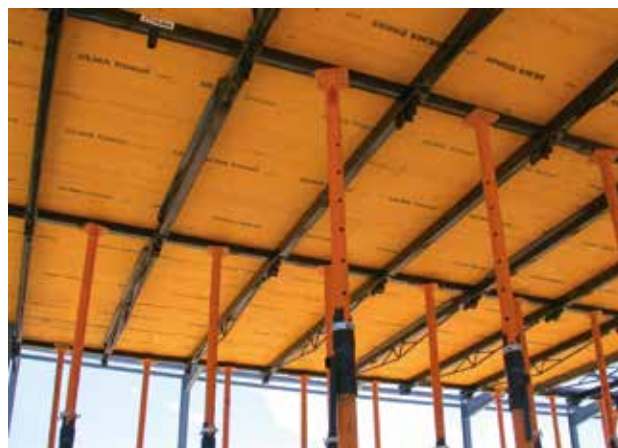
▲ Tablero Tricapa Trimax en el encofrado horizontal RAPID ▲
