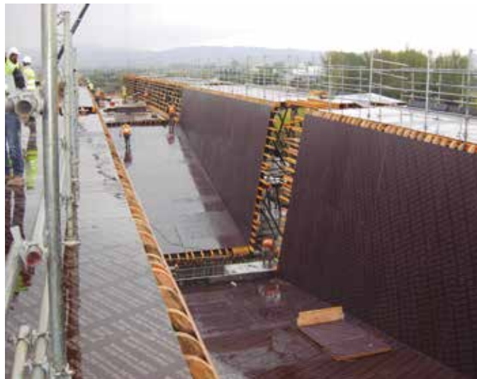
▲ Tablero fenólico como superficie encofrante en el encofrado ENKOFORM H-120 en la ejecución de viaducto
