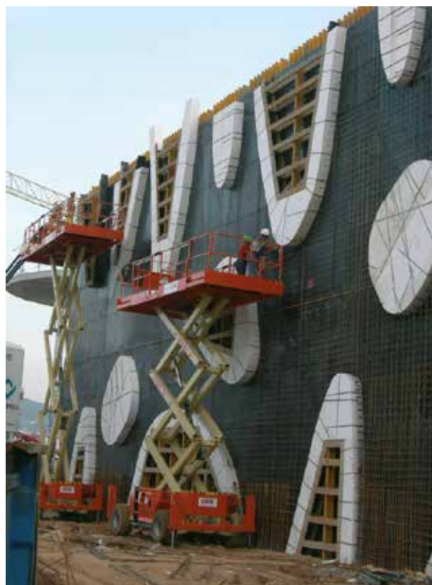
▲ Acabados de gran calidad en muros vistos obtenidos con el tablero fenólico en el encofrado vertical ENKOFORM V-100
