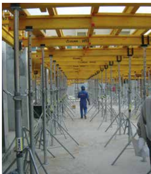
▲ Vigas VM-20 en el encofrado horizontal ENKOFLEX
