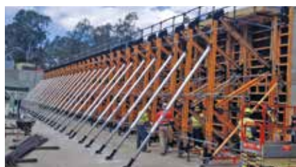
► Apuntalamiento en encofrados a una cara
