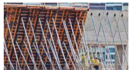
► Apuntalamiento en muros inclinados
