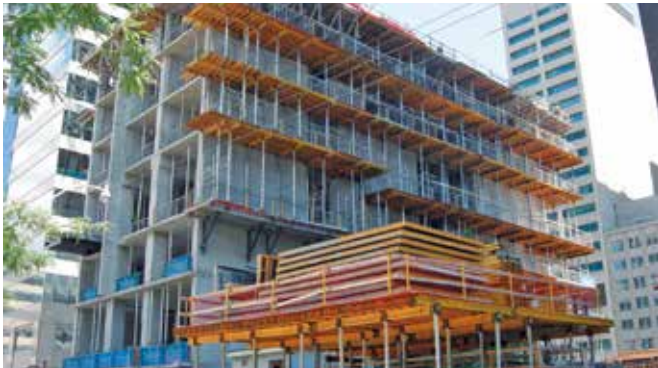
► Encofrado de vigas de madera ENKOFLEX
