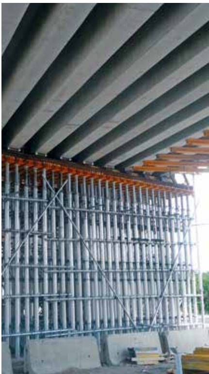
► Apeo en puente
