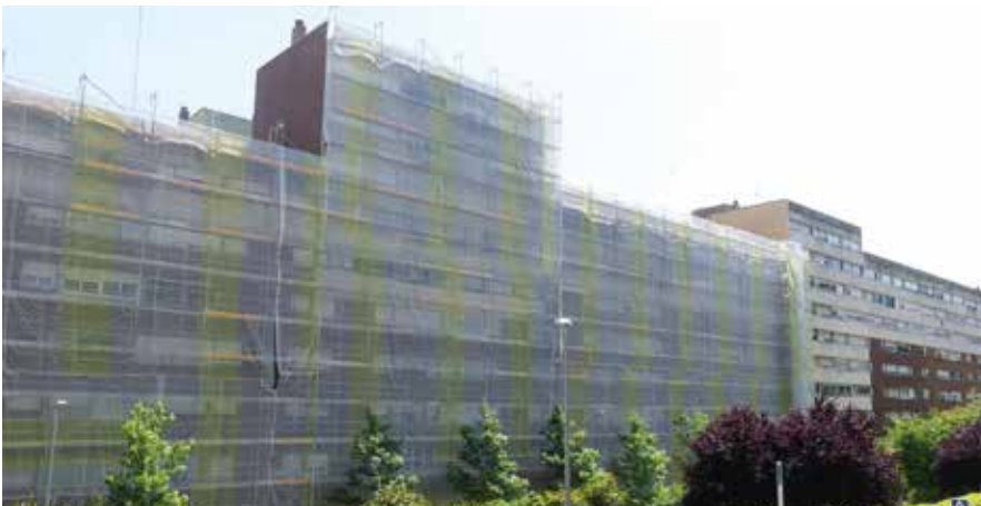
► Edificio en barrio de Canyelles - BARCELONA
