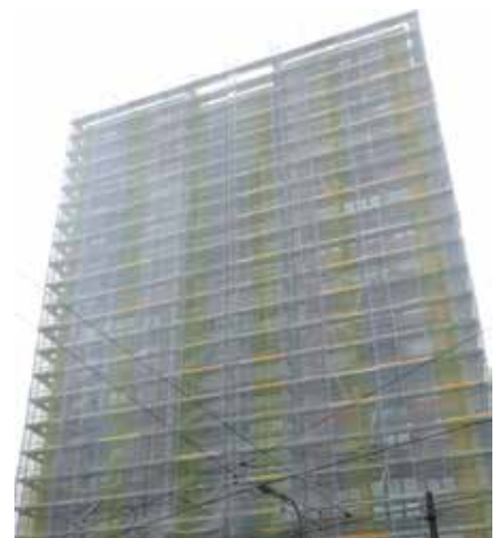
► Edificio en C/ Autonomía 53 - BILBAO
