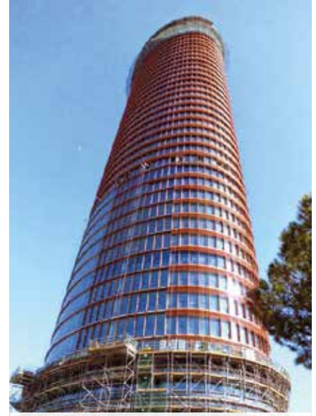
► Torre Pelli - SEVILLA
